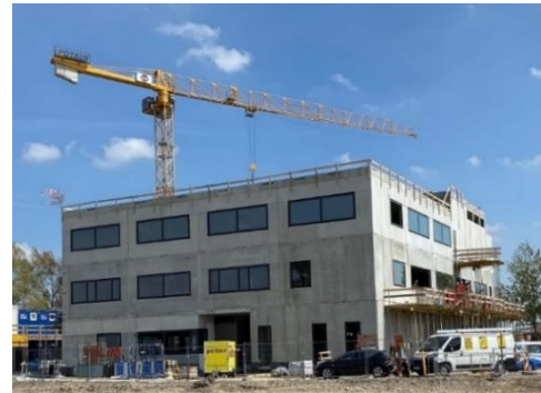
Fortschritt der Bauarbeiten (Mai 2021)
